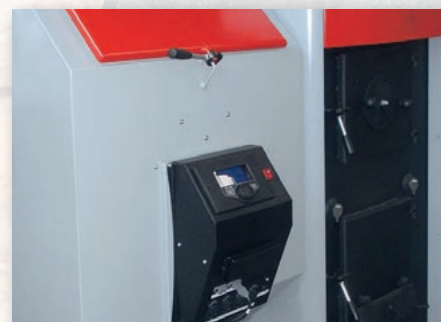
Umístění regulace na kotli
